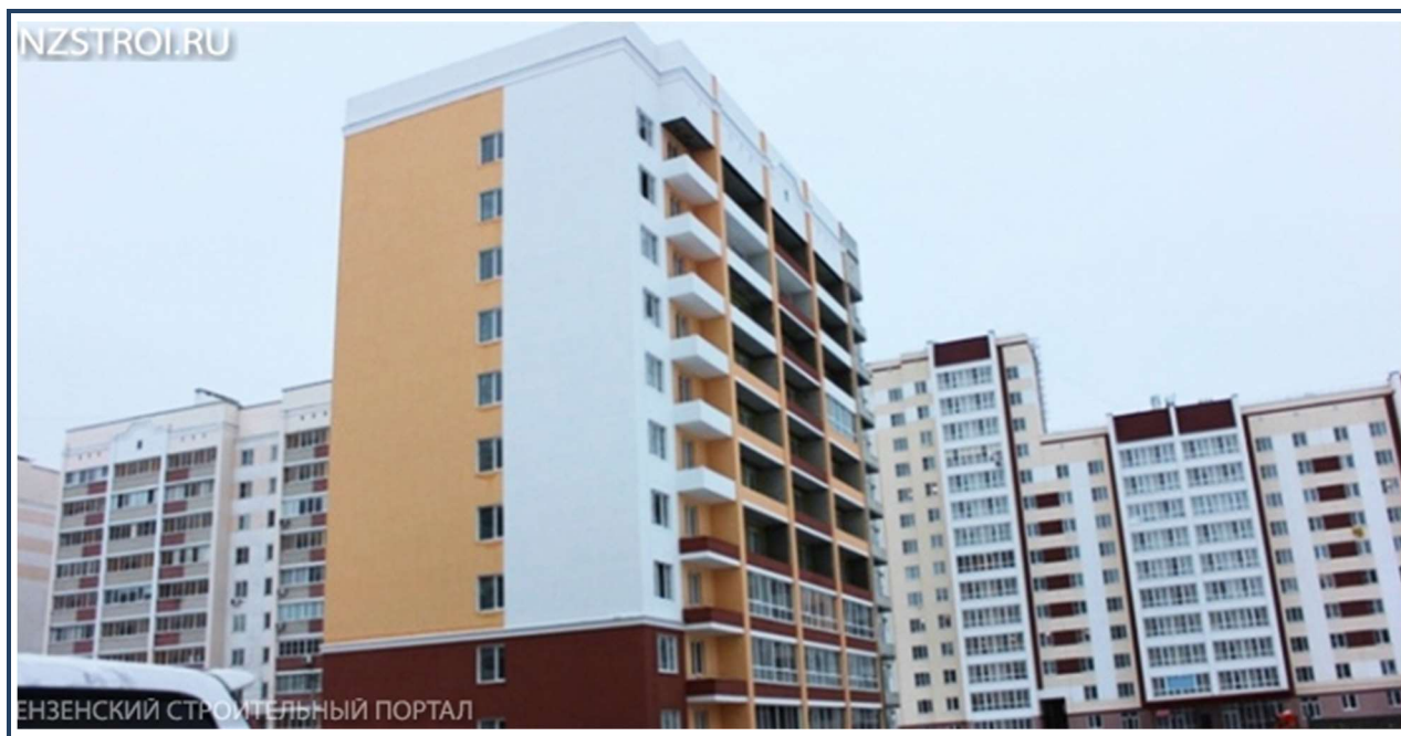
Рисунок 3. Фотография оцениваемого объекта по состоянию на 2016 г.
